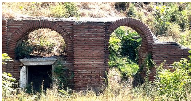
Fig.9 Opus testaceum– Tomis – Therme
