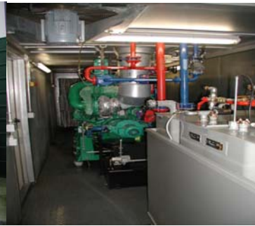
Fig. 11. Gas motor
